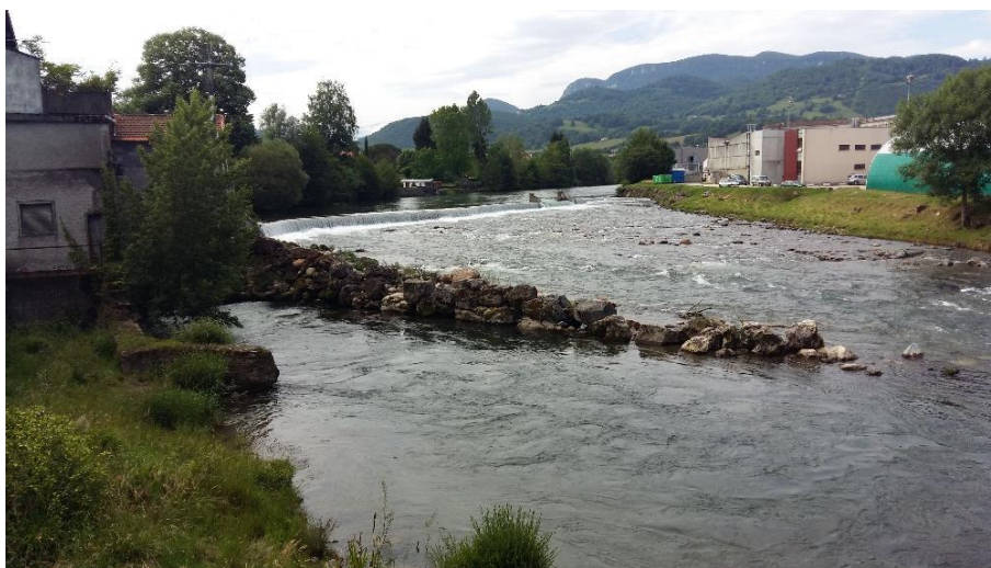
Figure 50 : Vue d'ensemble du TCC, de la centrale et du plan d'eau amont
