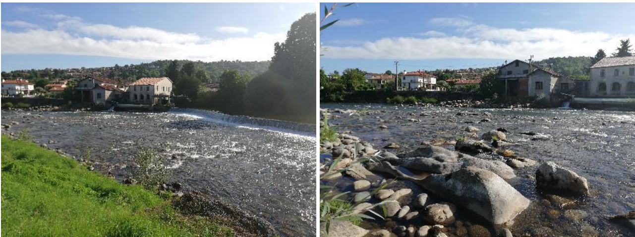
Figure 59 : Station de relevés IBG aval (TCC du Moulin de la Fonderie)
