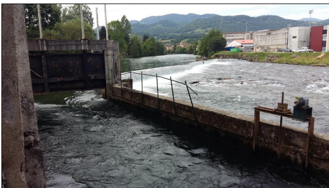
Figure 14 : Canal d'amenée et plan d'eau anthropique créé par le barrage en amont du TCC du Moulin de la Fonderie
