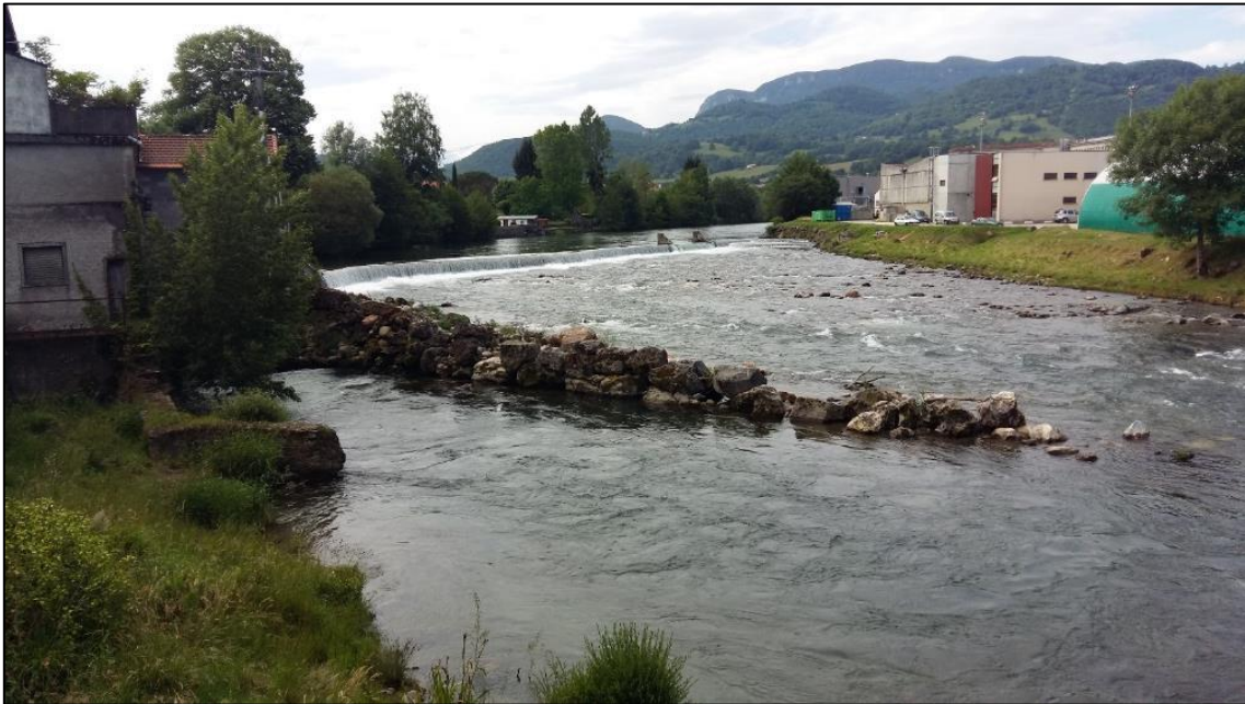
Figure 15: Canal de fuite de la centrale du Moulin de la Fonderie
